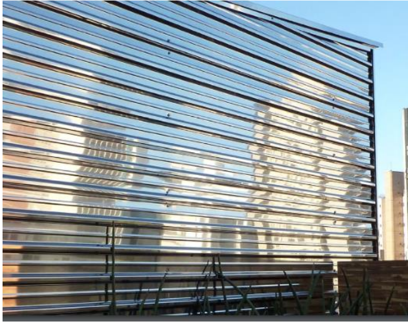
Telhas em aço inox
